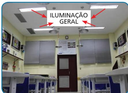
Foto 3 – Sistema de iluminação combinada
