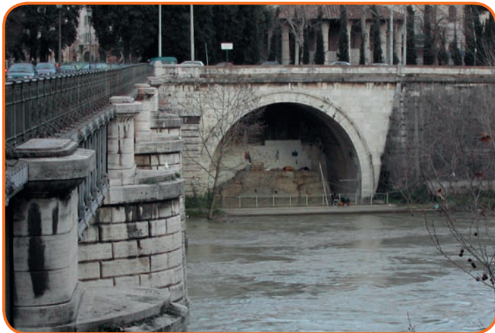
A Cloaca Máxima foi construída na antiga Roma, no final do século VI a.C., e funcionou como rede de esgoto, recebendo os dejetos da cidade e permitindo que fossem despejados no Rio Tibre, o qual, por sua vez, desemboca no mar. Nos dias de hoje, está desativada, mas a sua “boca” (a saída para o Tibre) ainda pode ser vista, embora esteja selada.
